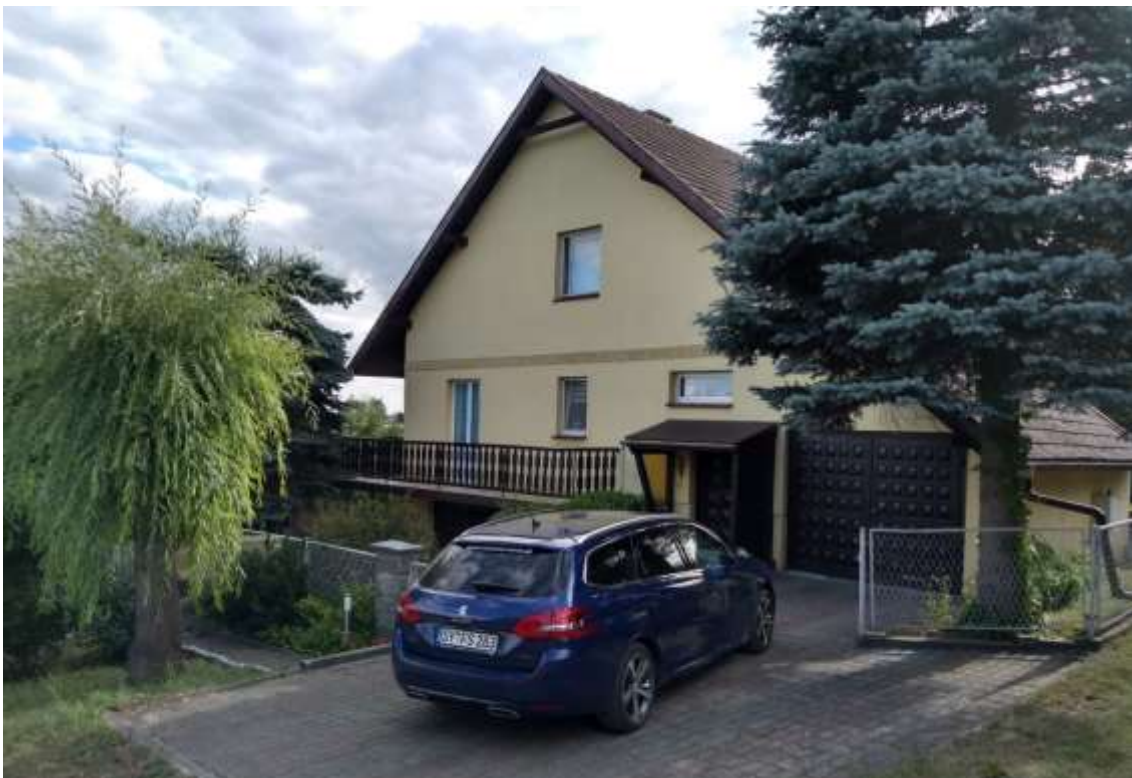
Eingangsbereich des Hauses „Anna-Charlotte“.- Aufnahme: Frank-Rainer Seelert
