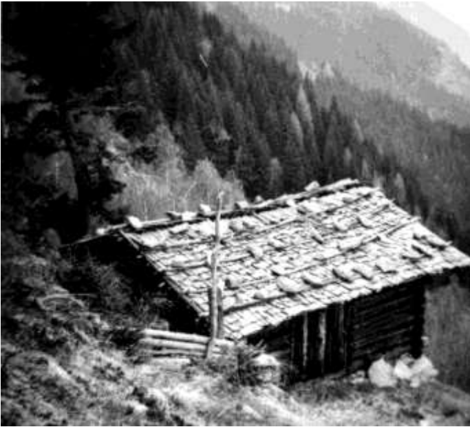
In dieser Almhütte wurde Luis Amplatz ermordet
