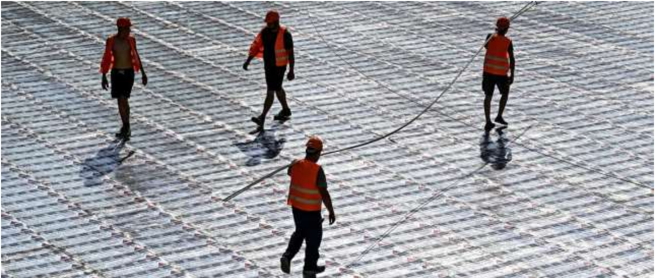
Bauarbeiten in Saporischschja im Südosten der Ukraine.- picture alliance / Photoshot
