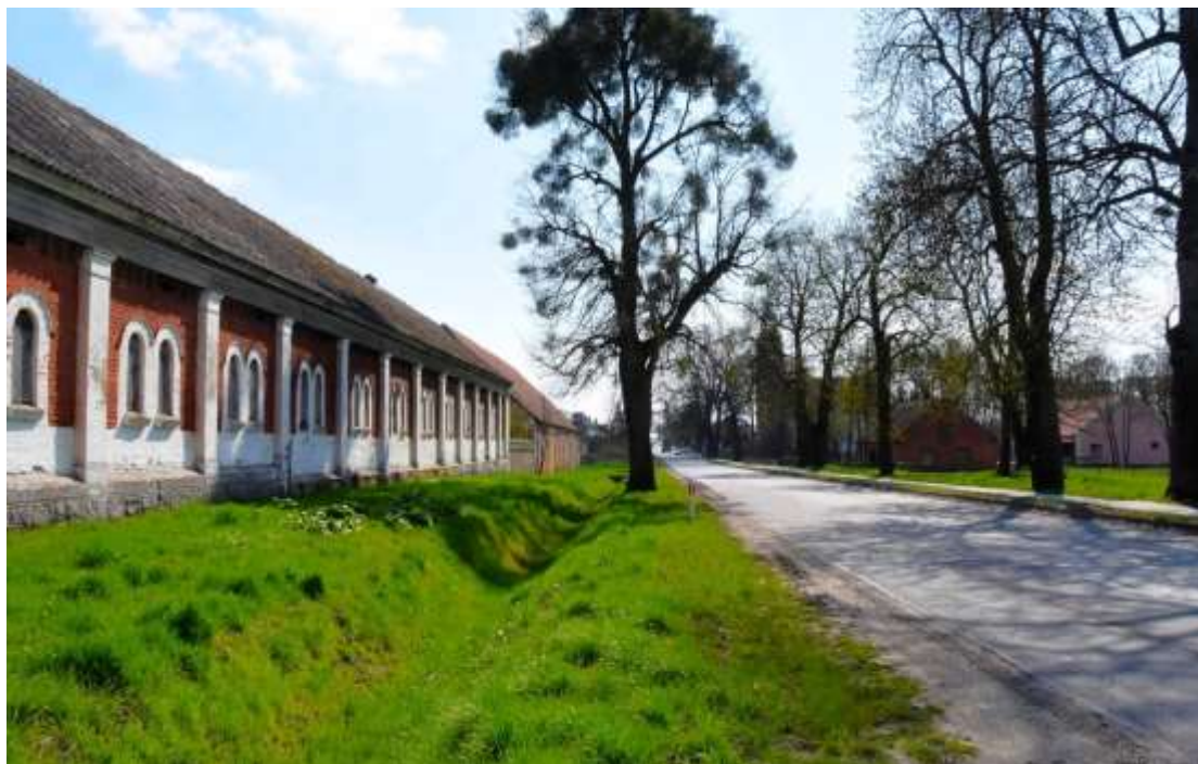
Abb. 12: Kamieniec/Finckenstein, Richtung Susz/Rosenberg 98
