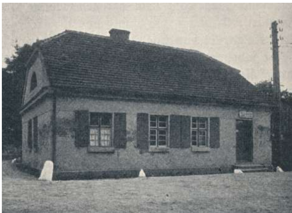
Abb. 2: Ehemaliges Chausseehaus in Altfelde/Stare Pole. 19
