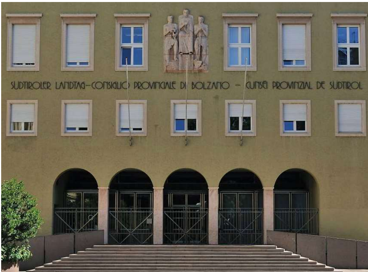
Portal des Südtiroler Landtages in Bozen
