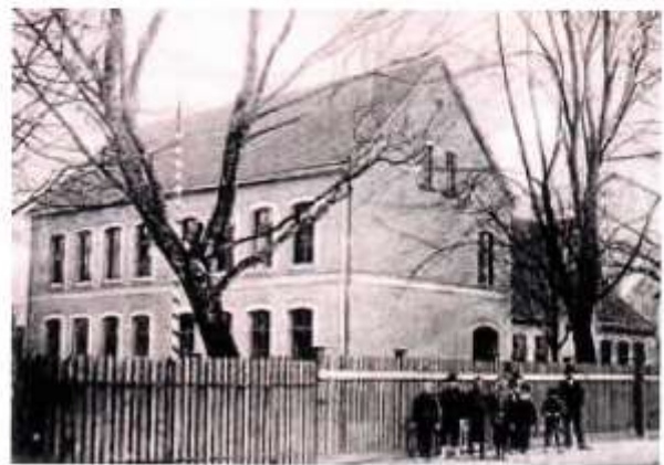
Die spätere Mittelschule in der Kirchstraße
