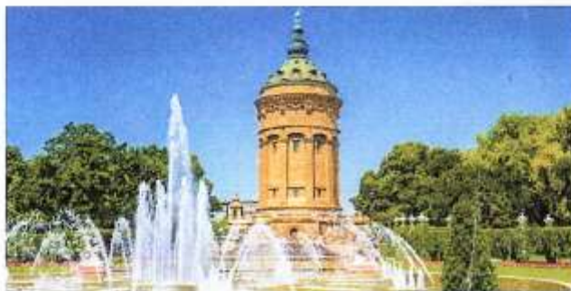
Der Mannheimer Wasserturm.
