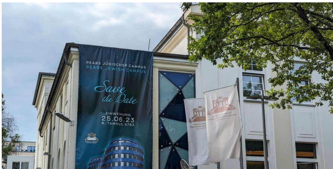
Der neue jüdische Campus an der Westfälischen Straße.- Bild: BACW/Brühl
