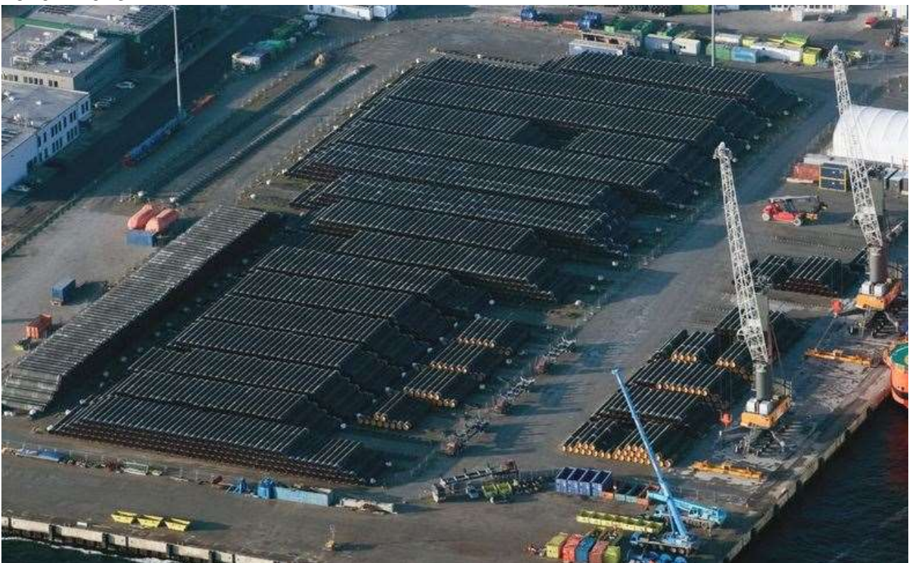
Rohre für Nord-Stream 2 auf Lager in Rügener Hafen
