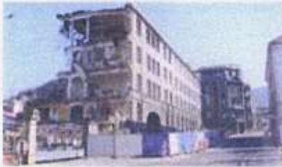
Der Abriss ist in vollem Gange. Bis zum Fensterstein hinaus der Dachstuhl ist gerettet.
