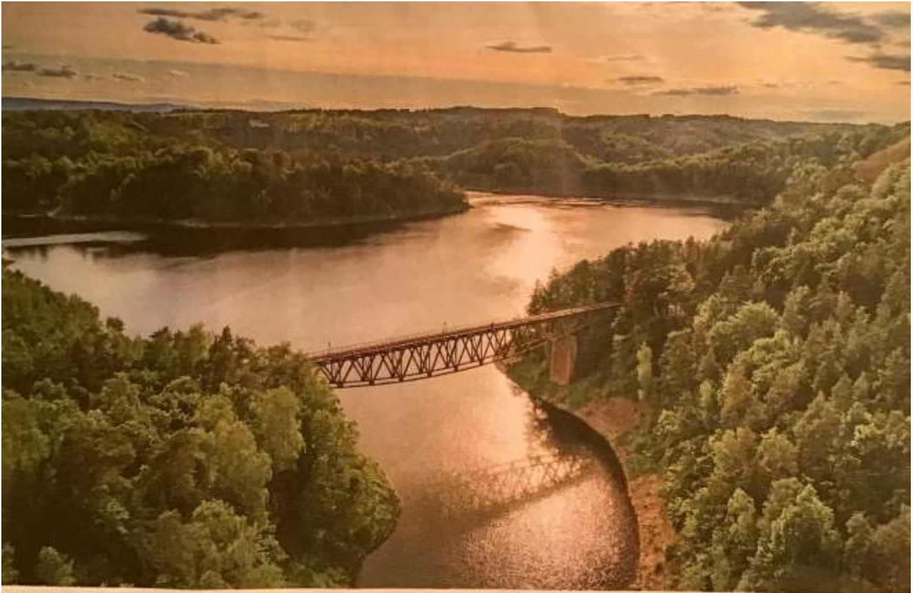
Still ruht der See; Doch bald soll es hier ordentlich krachen, wenn die Brücke über die Bobertalsperre für den nächsten „Mission: Impossible“-Film gesprengt wird. Foto: Peter Mischak
