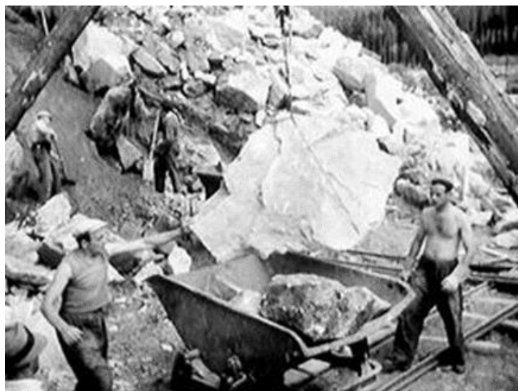
Bau des Lipno-Stausees (Foto: Tschechisches Fernsehen)
