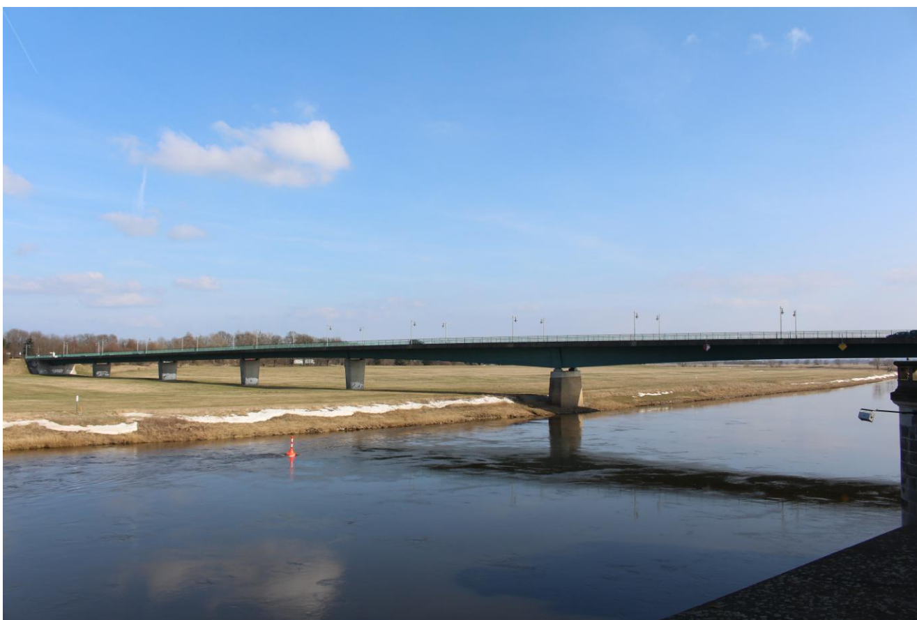
Die Elbebrücke Torgau, eine 509 m lange Straßenbrücke, die in Torgau die Elbe bei Stromkilometer 154,5 überspannt, wurde von 1991 bis 1993 erbaut und liegt im Zuge der Bundesstraße 87, die Leipzig mit Frankfurt (Oder) verbindet
