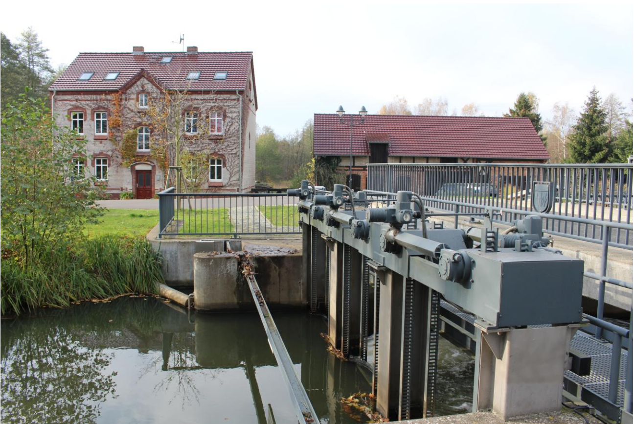
Schleuse an der Maustmühle
