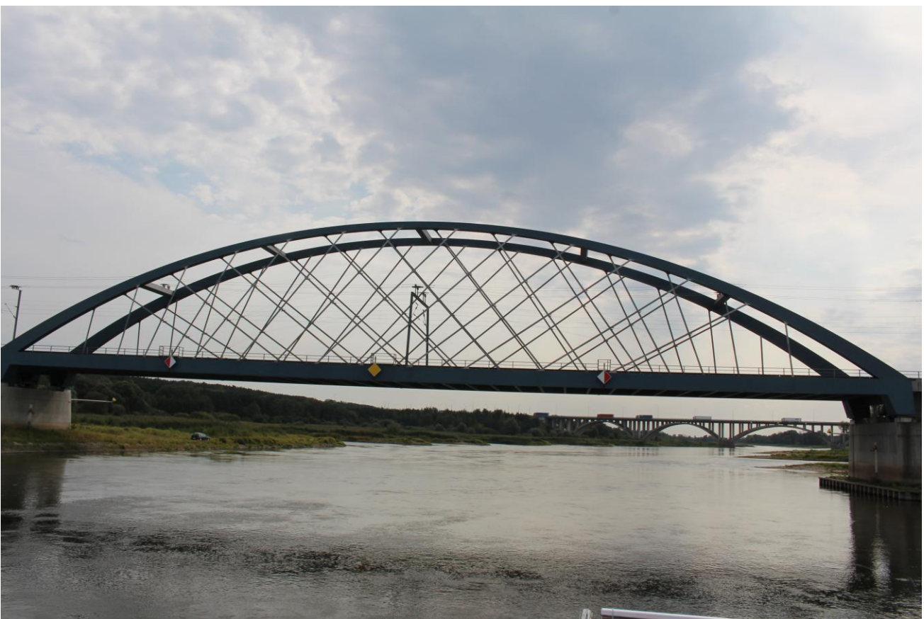
Eisenbahnbrücke (vorn) und Autobahnbrücke (hinten)
