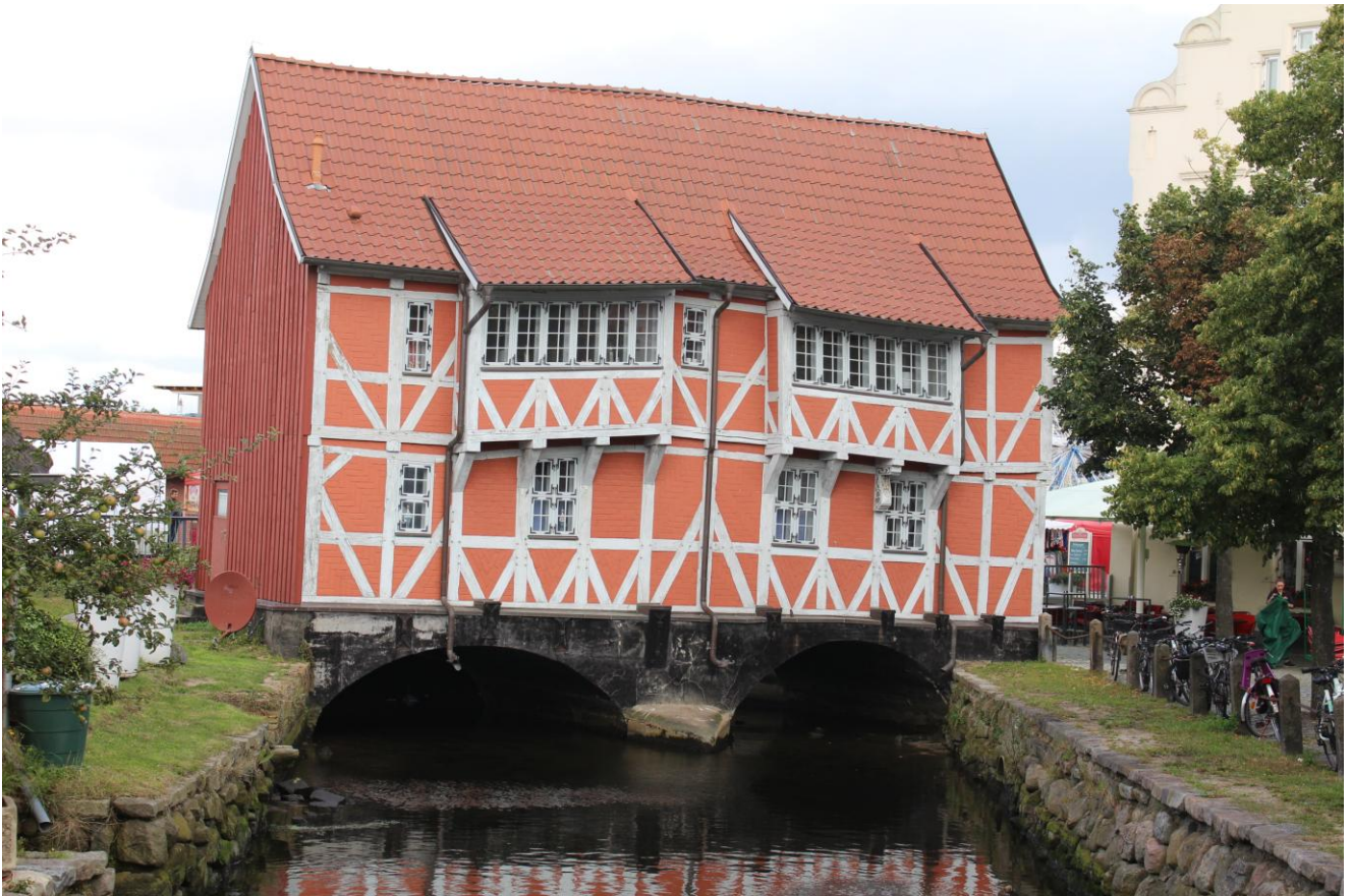
Wismar am Rande der Altstadt, Runde Grube 4: sogenanntes Gewölbe
