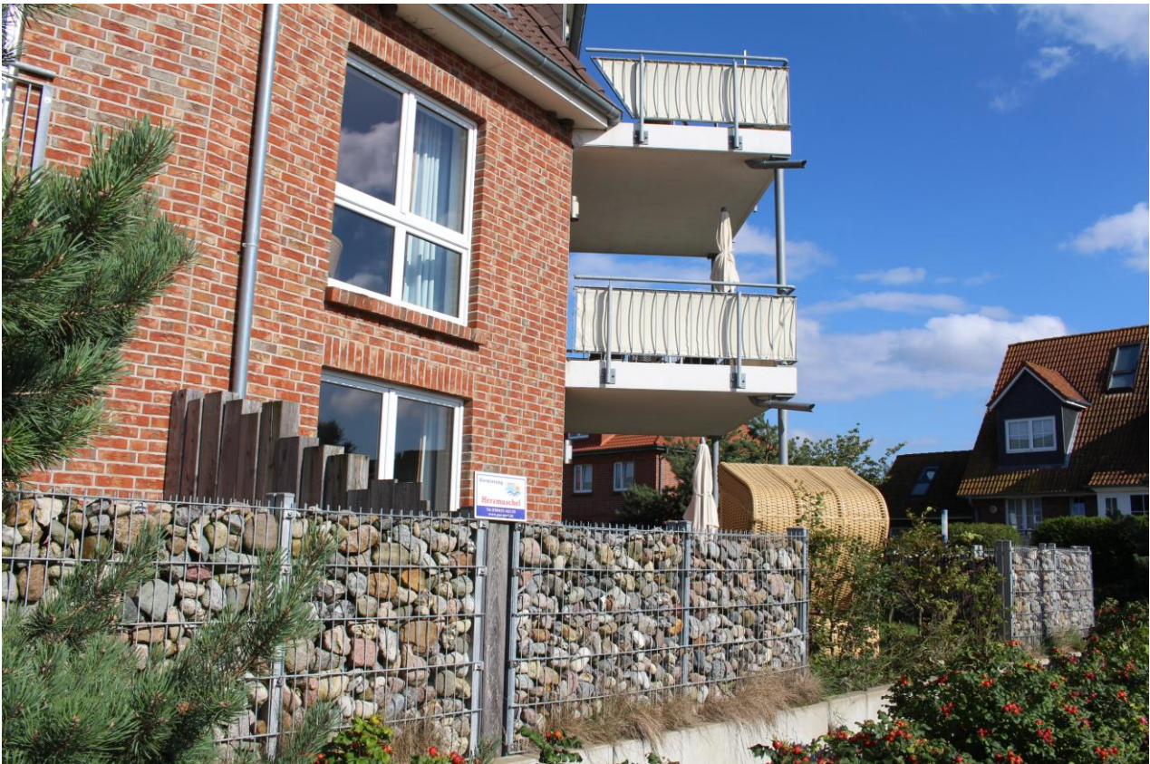
Timmendorfer Strand: Feldsteingeröll verpackt ergibt eine kompakte Mauer
