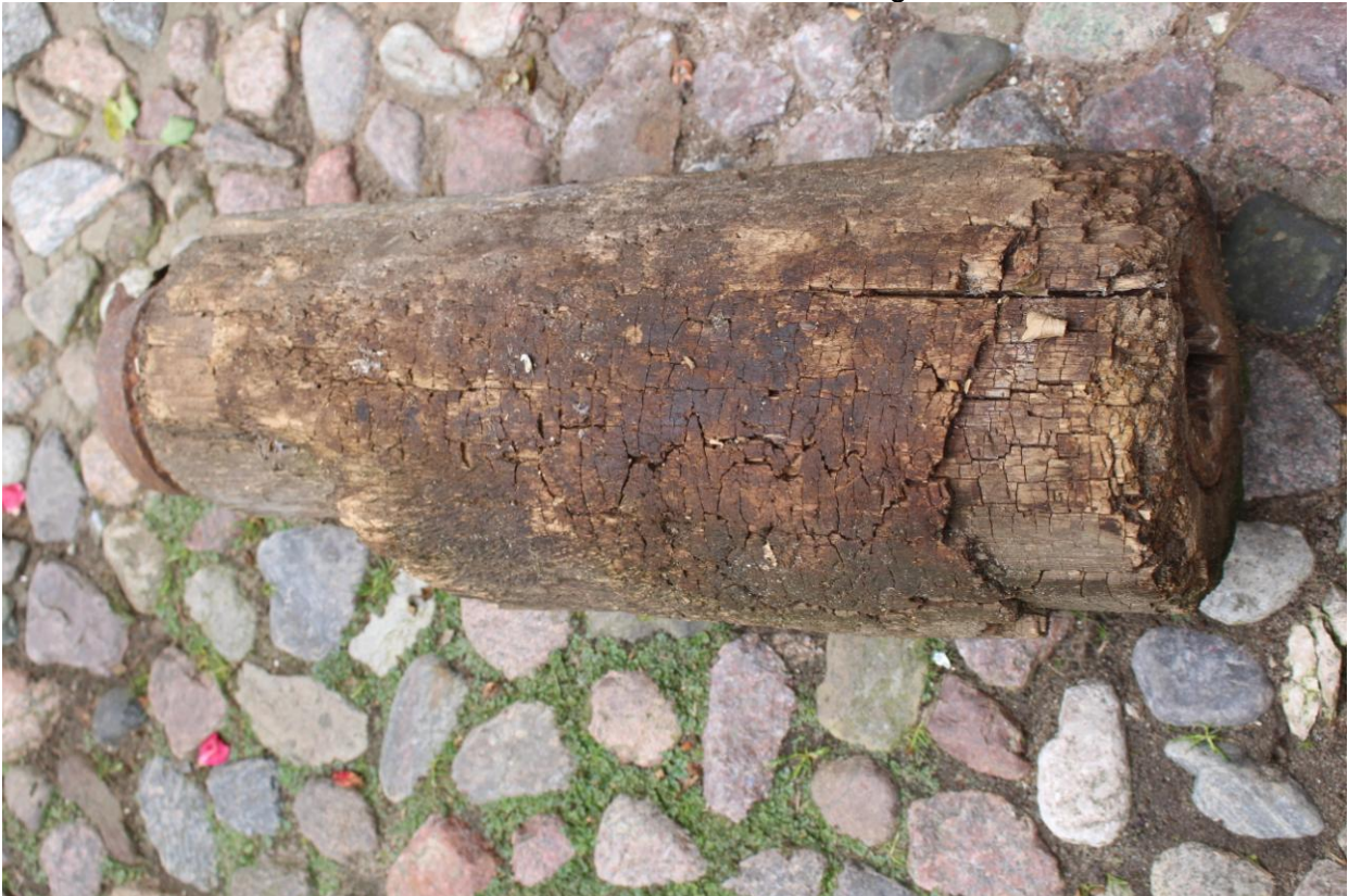
Wismar, Teil einer alten hölzernen Wasserleitung
