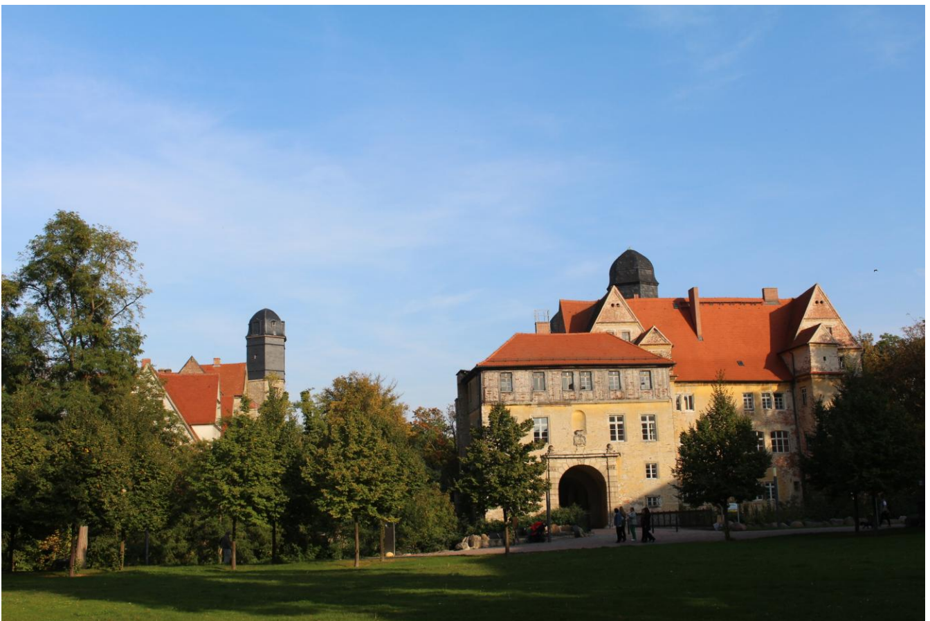
Blick von Westen auf den Bereich des Schlosses
