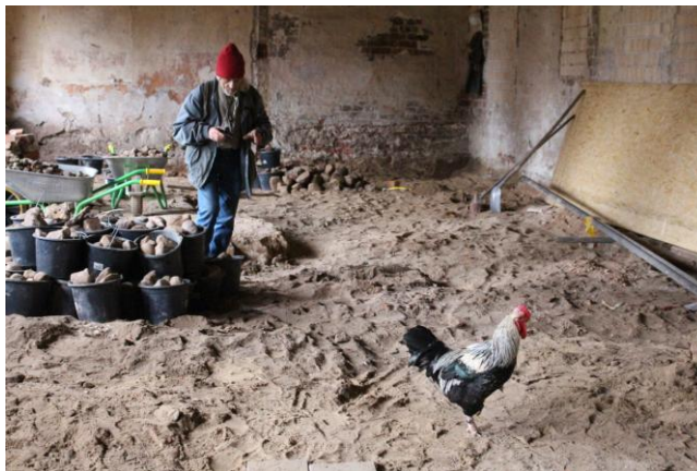
In der Propstei wird der alte Fußboden ersetzt
