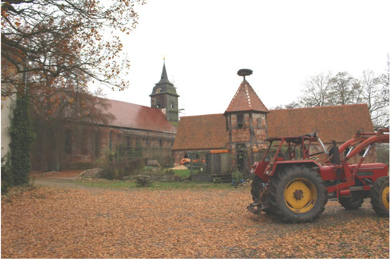
Klosterkirche und Propstei, davor Taubenhaus
