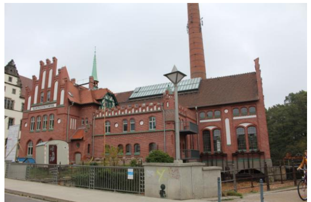
Das alte Elektrizitätswerk
