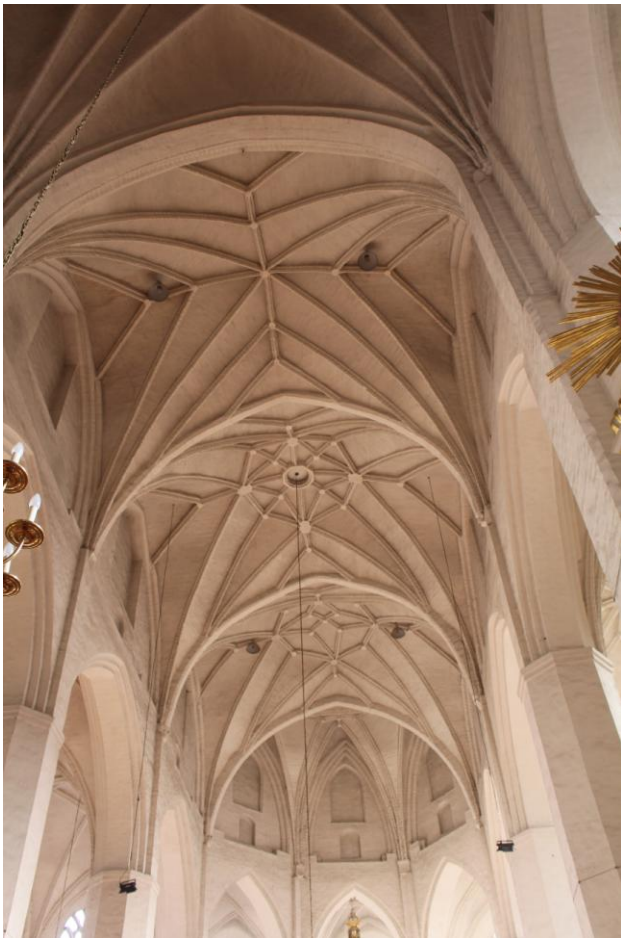
Gewölbe im Hauptschiff
