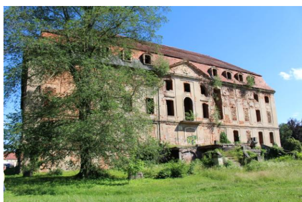
Pförten (poln. Brody): Ruine des Brühlschlusses vom Park her
