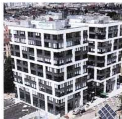
zentrale von Schneider Electric.
