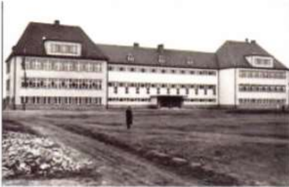
Volksschule an der Dammsstraße vor der Einweihung 1936
