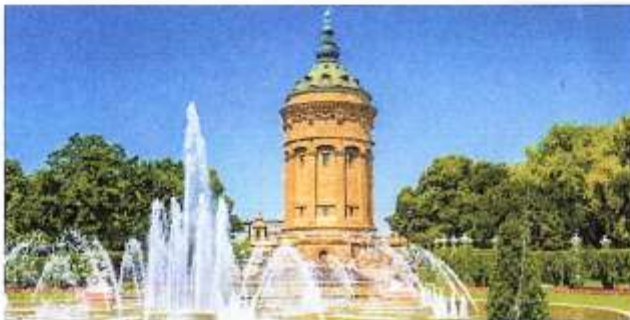
Der Mannheimer Wasserturm.
