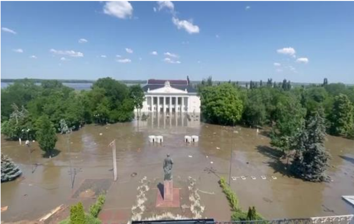
Nowa Kachowka1 überschwemmt nach «Sabotage» auf Damm des Hydrokraftwerks
