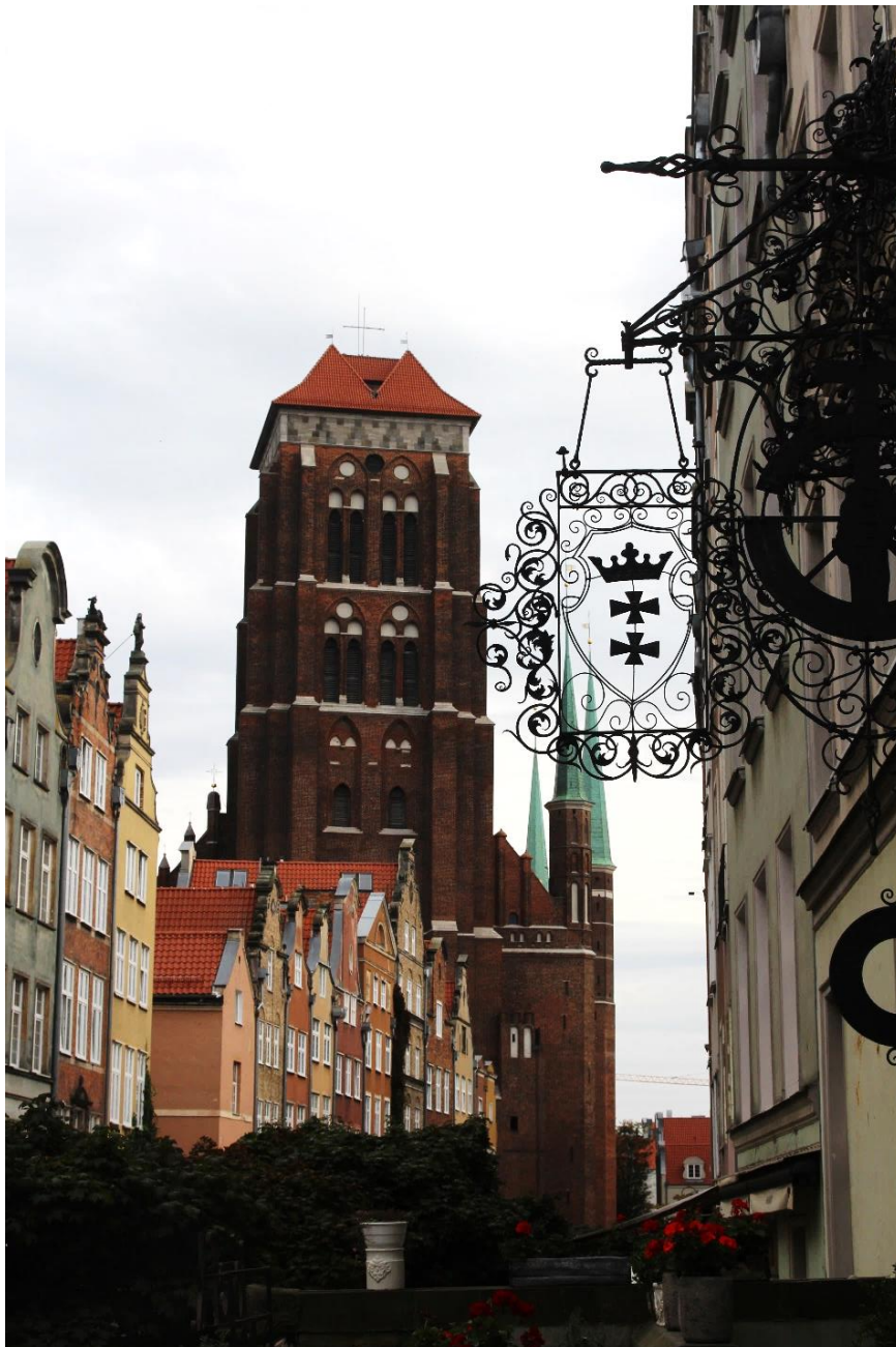
Danzig, Blick von Westen in der Brotbänkegasse auf die Marienkirche.- Aufnahme: Reinhard M. W. Hanke, 08.10.2022
