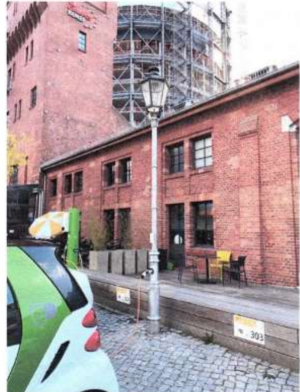
Historische Berliner Laterne mit modernster Technik, Lade säule von ubitricity auf dem EUREF-Campus.
