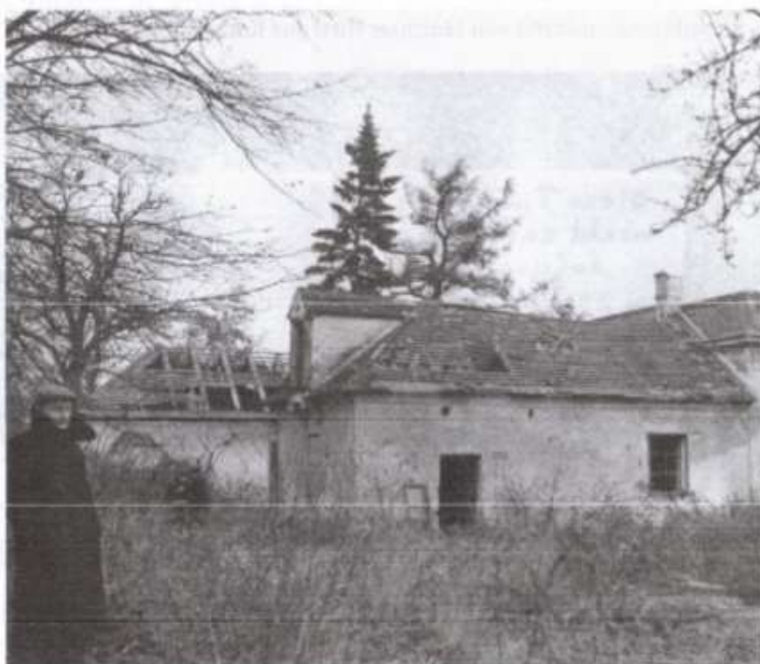
...a myslivnu před demolicí 1956 ... und auf das Forsthaus vor dem Abbruch 1956
