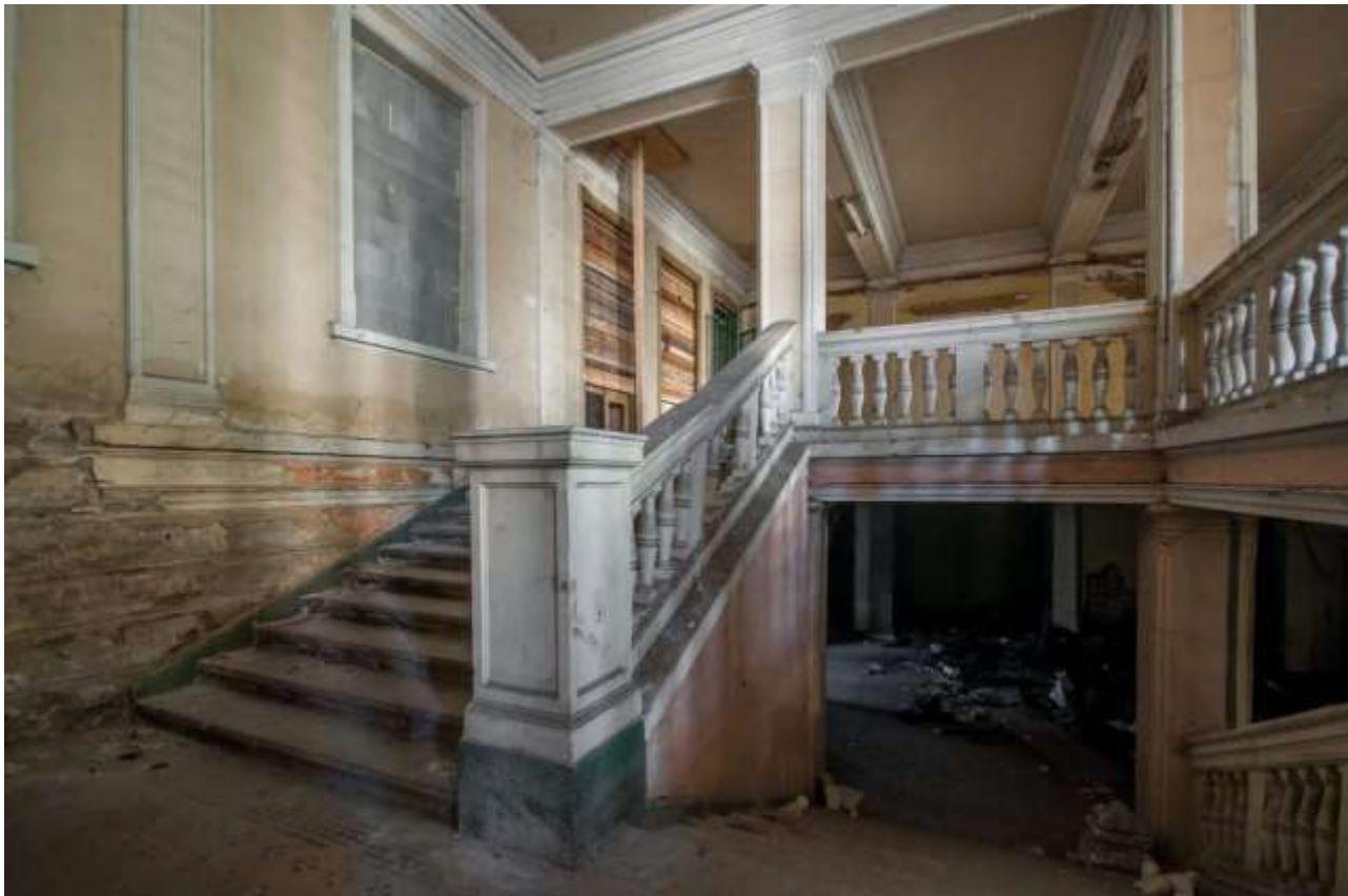
Bahnhof Vyšehrad. Foto: Radomír Kočí / Prázdné domy
