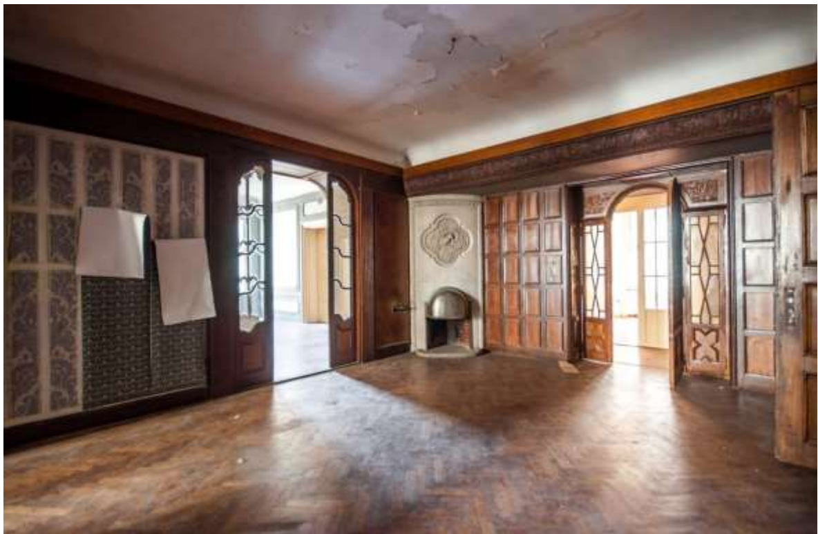
Im Gebäude des Assekuranzvereins der Zuckerindustrie in Prag. Foto: Radomír Kočí / Prázdné domy
